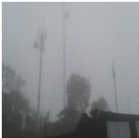
Ilustración 31: Antena del Sector Tres Banderas.
