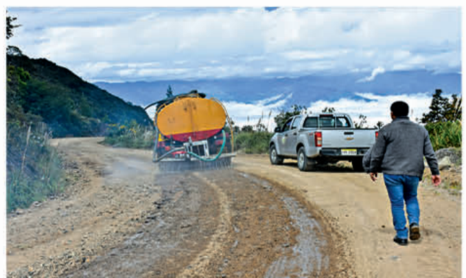
Luis Yáñez, alcalde de Pucará inspecciona mantenimiento vial
