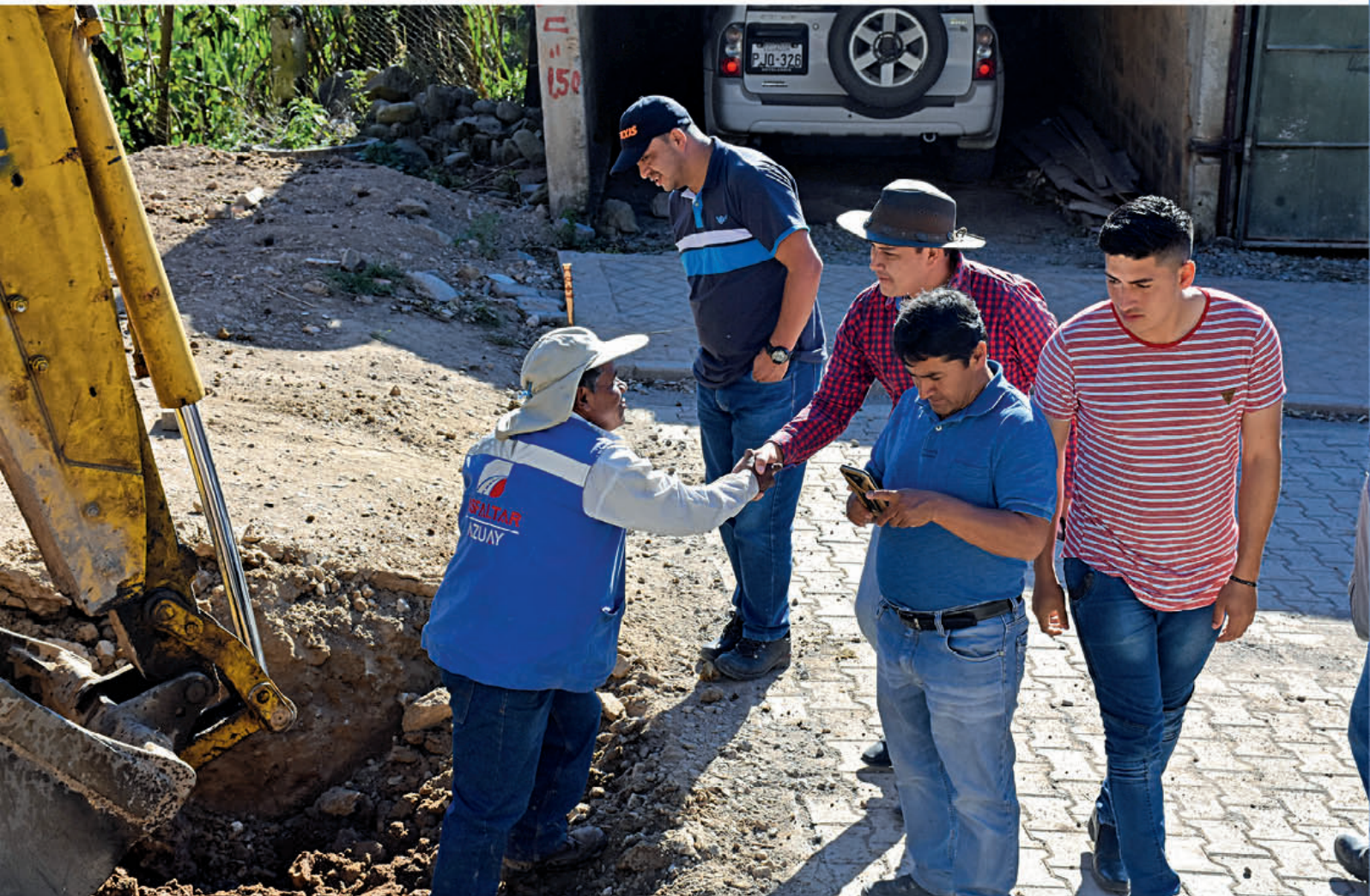
Luis Yáñez, alcalde de Pucará, durante inspección de obras en la parroquia San Rafael de Sharug
