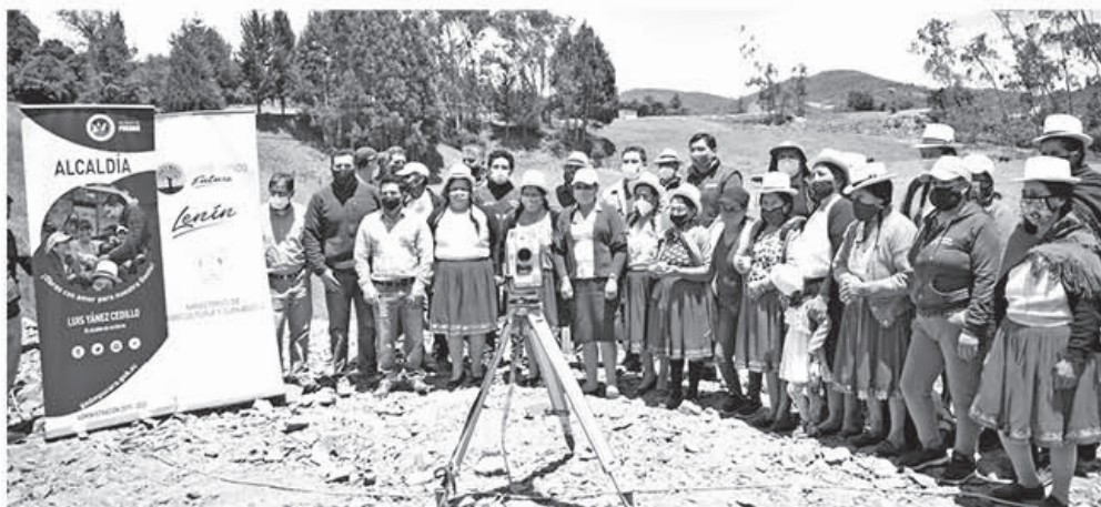
Autoridades municipales, técnicos del MAG y Asociación 9 de Marzo inician construcción de la planta de lácteos
