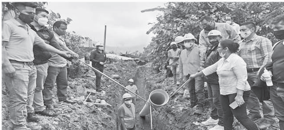
Alcalde Luis Yáñez y miembros del concejo cantonal colocan la primera piedra del sistema de alcantarillado.
