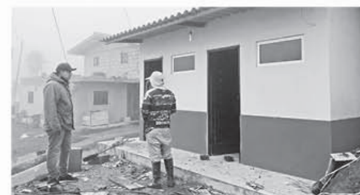
Baterias sanitarias en Tullusiri
