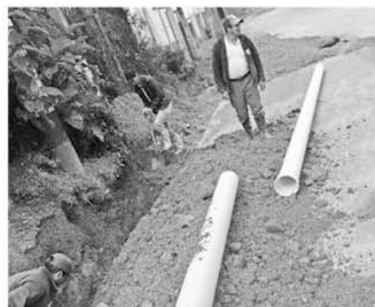
Reubicación de domiciliarias en el centro cantonal de Pucará
