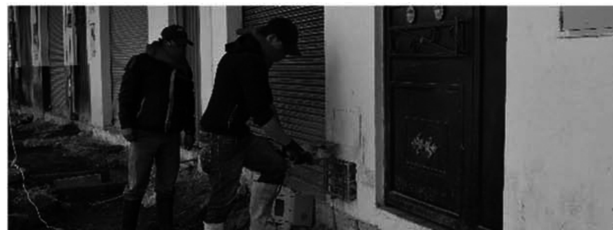
Trabajadores colocan los medidores de agua potable fuera de las viviendas
