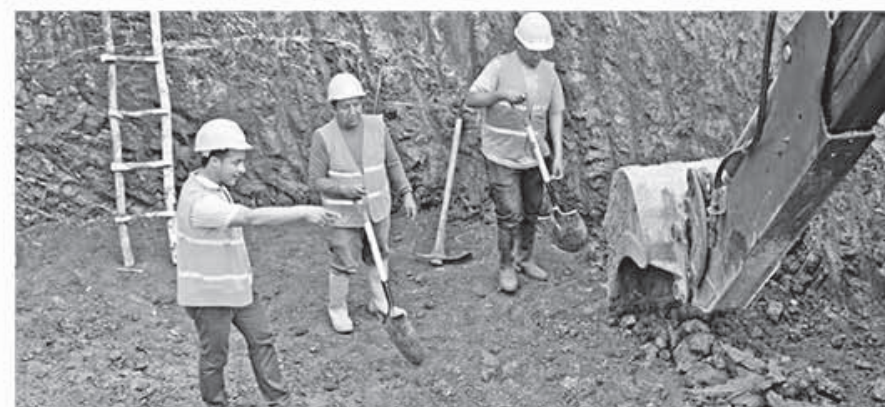
Construcción del sistema de agua potable en la comunidad de Gramalote
