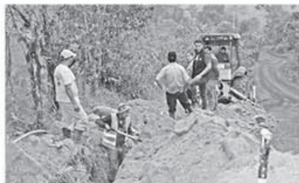
Rogelio Reyes, alcalde de Pucará realiza visita técnica para verificar los trabajos de construcción del sistema de agua potable en La Chonta.
